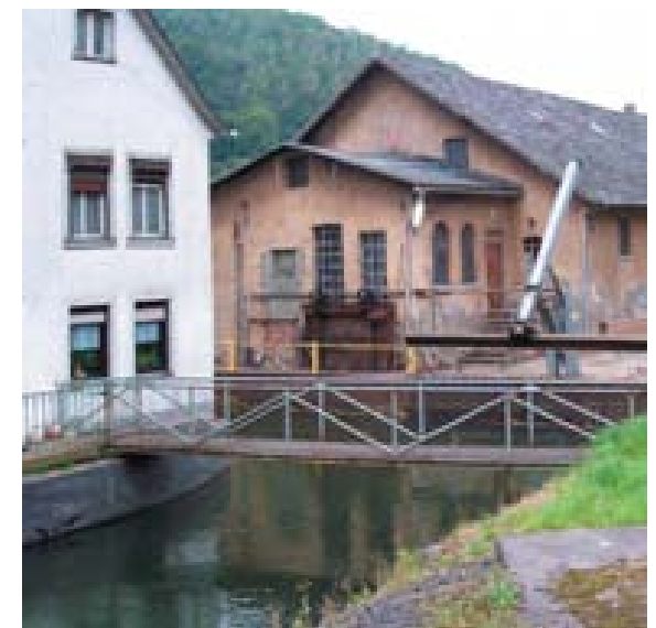
Kraftwerk an der Mühlenstraße
